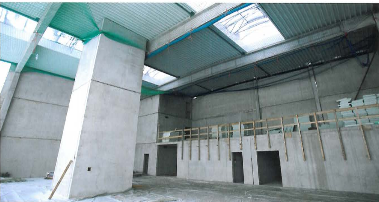
DER ROHBAU STEHT: Im Sommer 2013 wird das neue Nutzfahrzeug Zentrum in Bremen Hemelingen eingeweiht.
