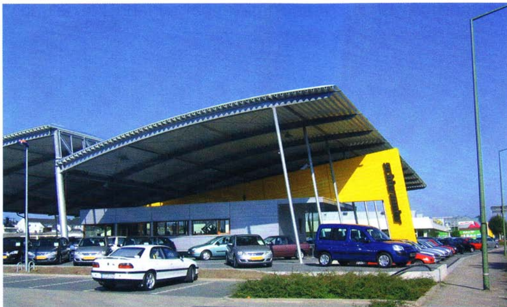
GW-Präsentation bei Opel Schiermeier: Sheddach-Konstruktion, die auch noch verglast werden kann
