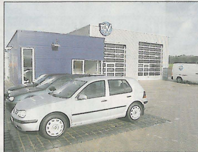
Blau-silbern zeigt sich die neue TÜV-Station: Im silbernen Gebäudeteil sind die Prüfanlagen für Pkw und Lkw, im blauen Teil Kundenraum und Büro. Foto: Trau
