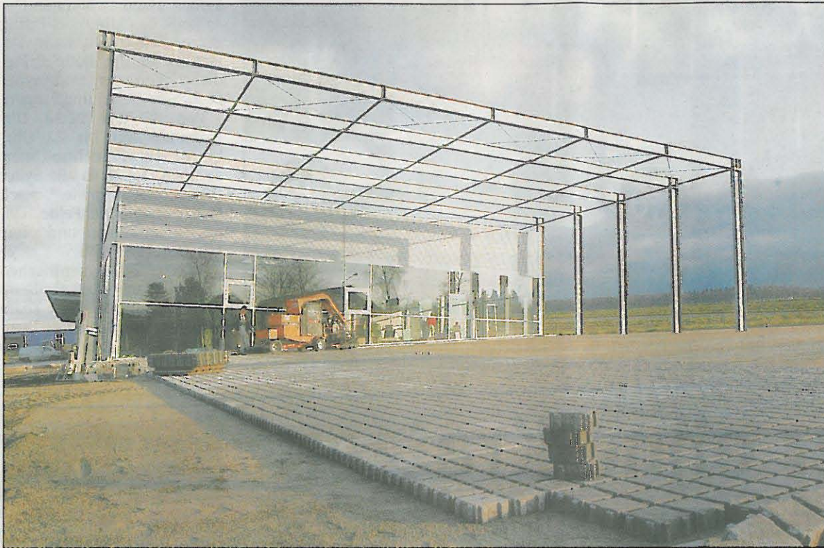
Schon in der Bauphase war das Dello-Gebäude ein „Hingucker“.
